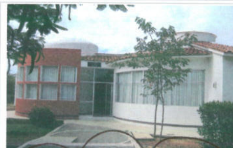
F5: Fachada Centro de libros
