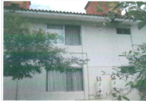
F2: Fachada posterior lado poniente
