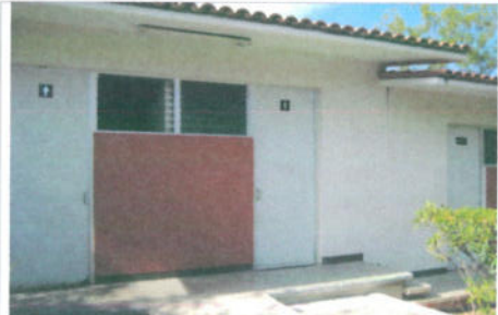
F4: Puertas CAPFCE del edificio de Aulas
