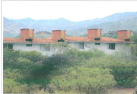
F1: Fachada posterior del Edificio
