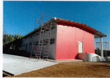
F2: ESTRUCTURA, ALBAÑILERÍA Y ACABADOS, CANCERÍA Y HERRERÍA, OBRA EXTERIOR.
