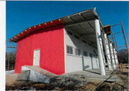
F4: ESTRUCTURA, ALBAÑILERÍA Y ACABADOS, CANCERÍA Y HERRERÍA, OBRA EXTERIOR.
