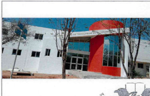
F4: ALBAÑILERÍA Y ACABADOS, HERRERIA Y CANCILLERÍA, OBRA EXTERIOR.
