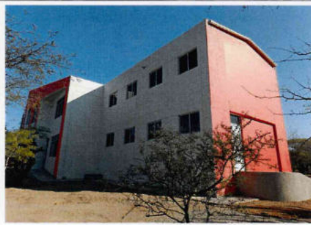
F2: ALBAÑILERÍA Y ACABADOS, HERRERIA Y CANCILLERÍA, OBRA EXTERIOR.
