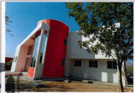
F3: ALBAÑILERÍA Y ACABADOS, HERRERIA Y CANCILLERÍA, OBRA EXTERIOR.
