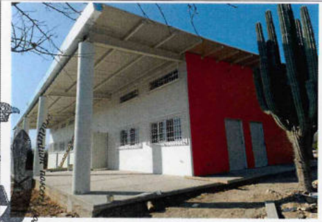
F3: ESTRUCTURA, ALBAÑILERÍA Y ACABADOS, CANCERÍA Y HERRERÍA, OBRA EXTERIOR.
