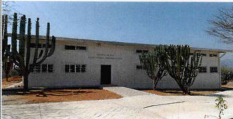
F1: ESTRUCTURA, ALBAÑILERÍA Y ACABADOS, CANCERÍA Y HERRERÍA, OBRA EXTERIOR.
